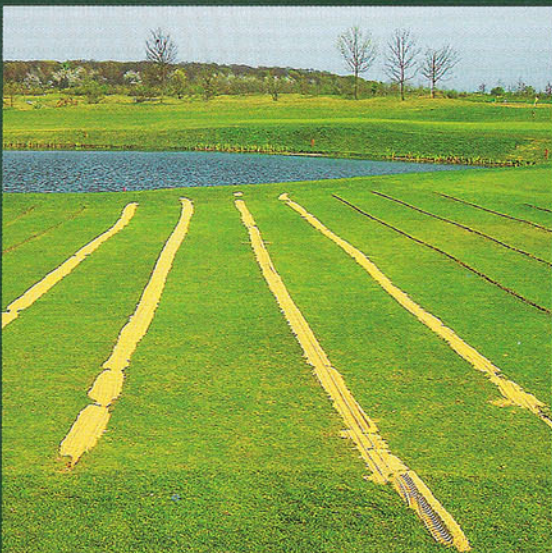
Die Schlitzlöcher wurden anschließend mit einer Rasentragschicht verfüllt.
