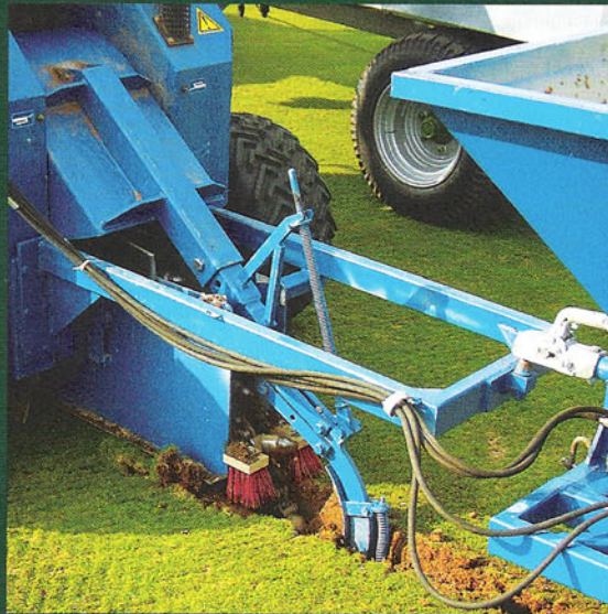
Mit einer Bodenfräse wurden die 7 cm breiten Schlitzlöcher hergestellt.
